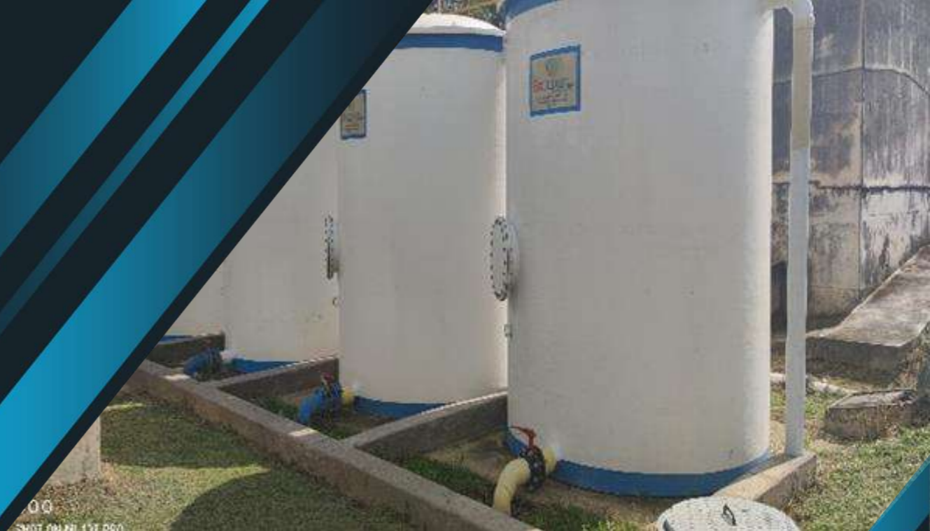
Instalación Filtros Anaerobios de Flujo Ascendente PTAR Municipal San Roque
