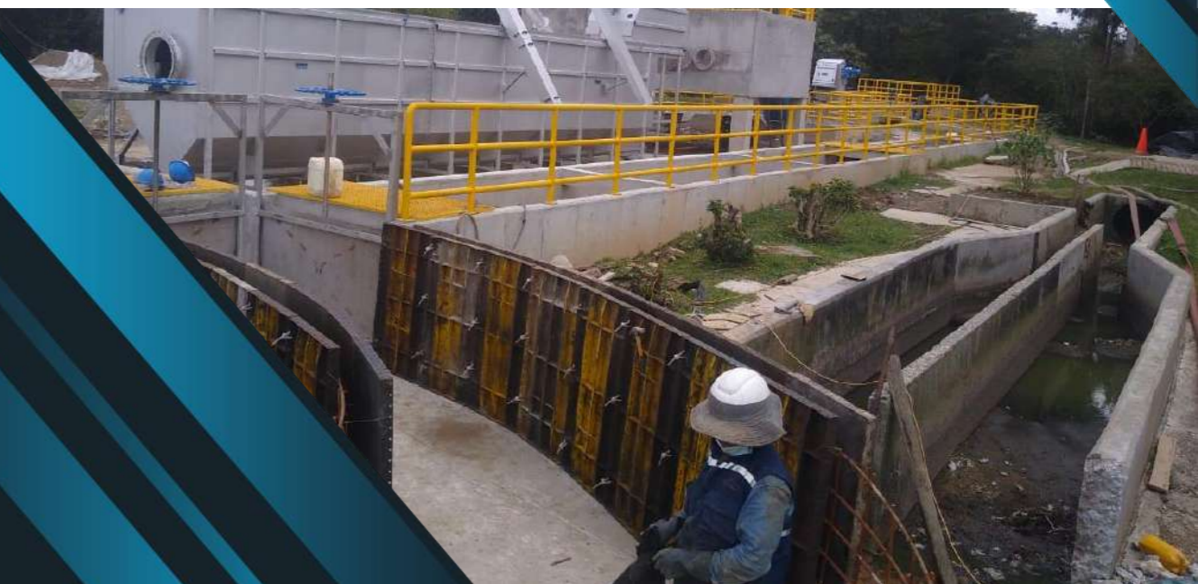
Obras de mecanización canal de entrada PTAR municipal La Ceja
