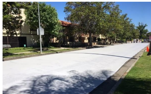
Figura 17. Obra terminada (Marín, 2017).
