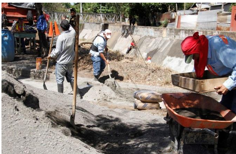
Figura 18. Trabajadores de Managua desarrollando los trabajos de recuperación del cauce (Lara, 2017).
