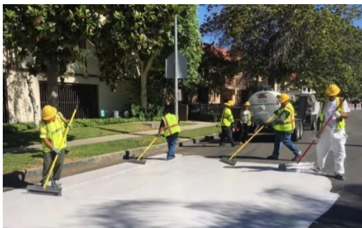
Figura 16. Pavimentación de las calles (Marín, 2017).
