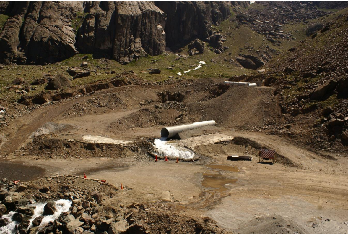
Figura 37. Fotografía de intervención en quebrada que atraviesa la UTH 134.
