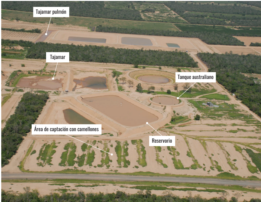
Figura 6.11. Sistema de captación y almacenamiento de agua. Chaco Central de Paraguay. Fuente: Foro de Agua - INTA Sáenz Peña (Harder, 2015).
