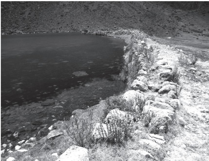
FOTO 1. SEGUNDA REPRESA DE YANACANCHA, CON MURO DE DOBLE HILADA.
