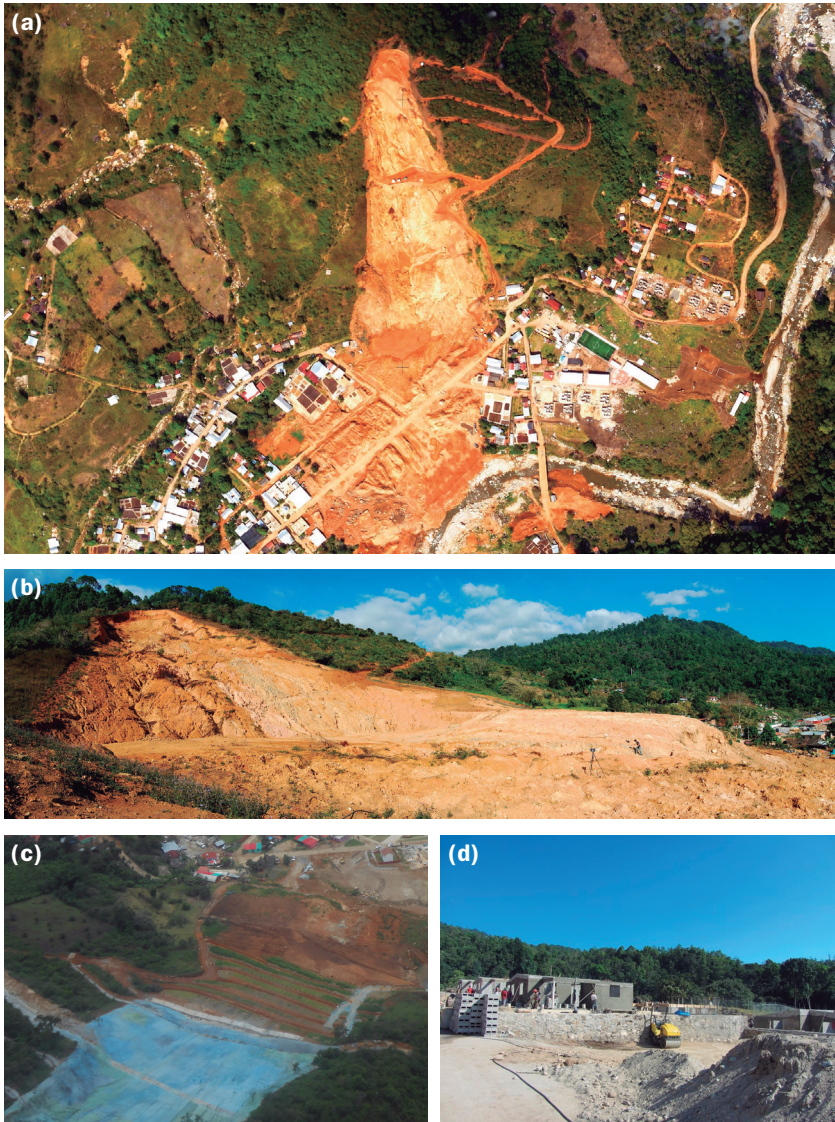
Figura 11.16. Localidad de La Pintada: (a) deforestación en diversas zonas del municipio de Atoyac de Álvarez (imagen de satélite Google Earth Pro); (b) deslizamiento desencadenado por precipitación el 16 de septiembre de 2013 (fotografía de Ricardo J. Garnica-Peña); (c) obras de mitigación (fotografía de la Subdirección de Dinámica de Suelos y Procesos Gravitacionales de la Dirección de Investigación del CENAPRED), y (d) construcción de viviendas para la relocalización de La Nueva Pintada (fotografía de la Subdirección de Dinámica de Suelos y Procesos Gravitacionales de la Dirección de Investigación del CENAPRED).
