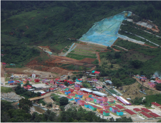
Figura 11.17. Obras de mitigación de la ladera afectada por el deslizamiento y reubicación de La Nueva Pintada en la planicie de inundación. Fuente: fotografía de la Subdirección de Dinámica de Suelos y Procesos Gravitacionales de la Dirección de Investigación del CENAPRED.
