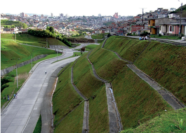
Figura 11.12. Obras de estabilidad y control de la erosión en Manizales y mantenimiento de las obras por parte de las Guardianas de la Ladera. Fuente: fotografías de Corpocaldas, Omar D. Cardona A. y Dora Catalina Suárez O.
