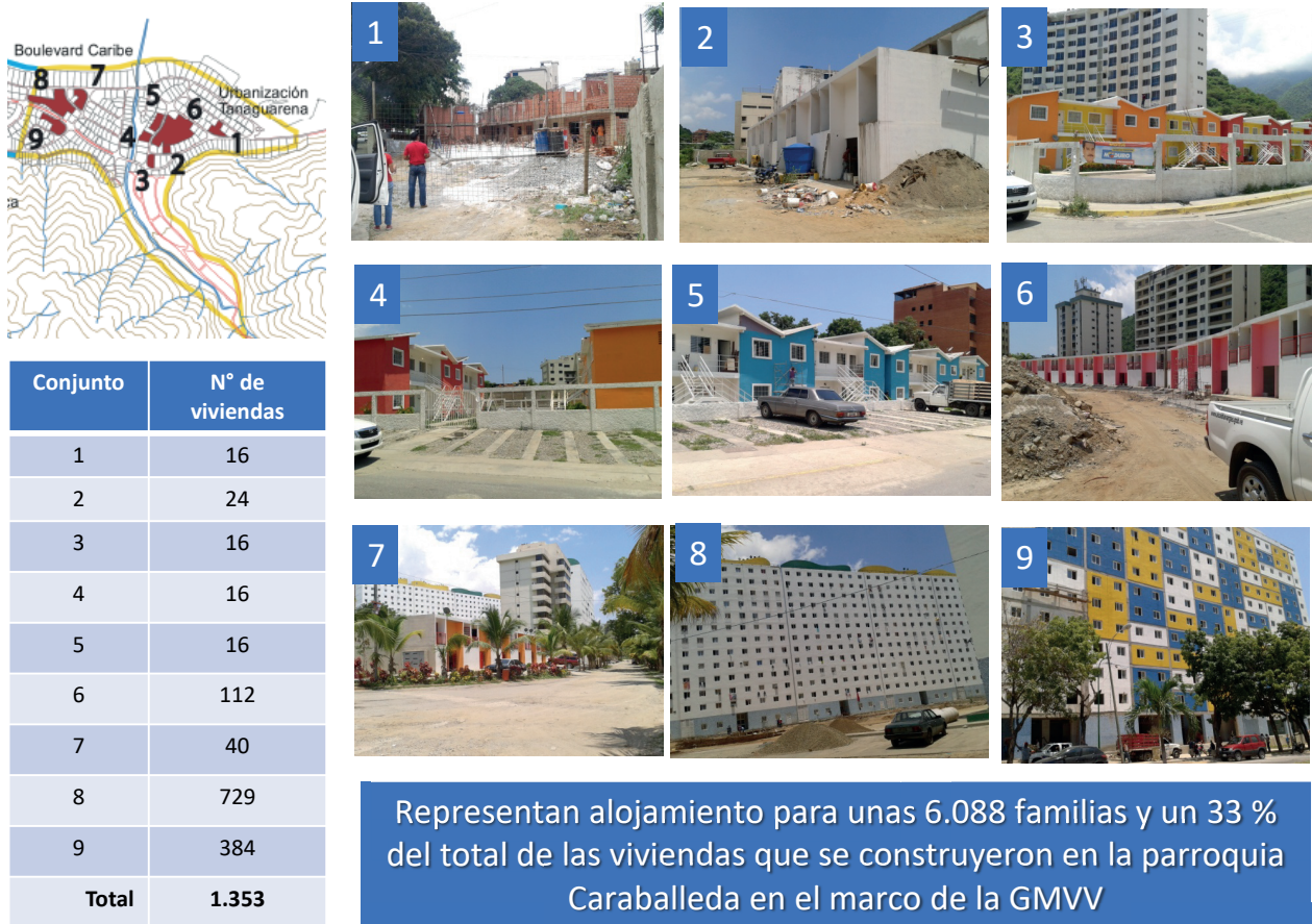
Figura 11.15. Nuevos urbanismos de la GMVV en las zonas de alta amenaza por inestabilidad de laderas (aludes torrenciales) en la cuenca del río Cerro Grande. Fuente: Mendes, 2014.
