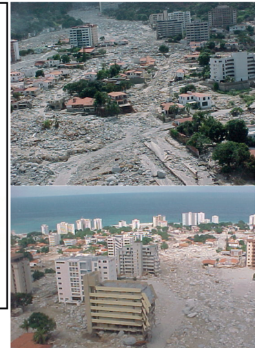
Daños en Caraballeda, 1999.
