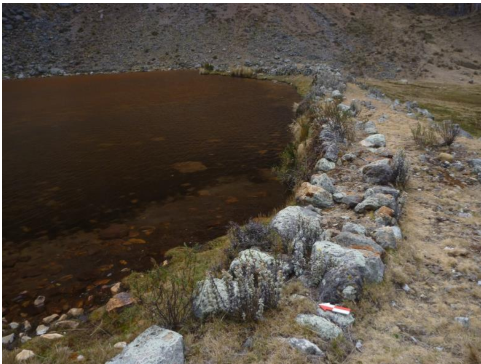
Foto 2 Segundo represamiento de Yanacancha con muro de doble hilada
